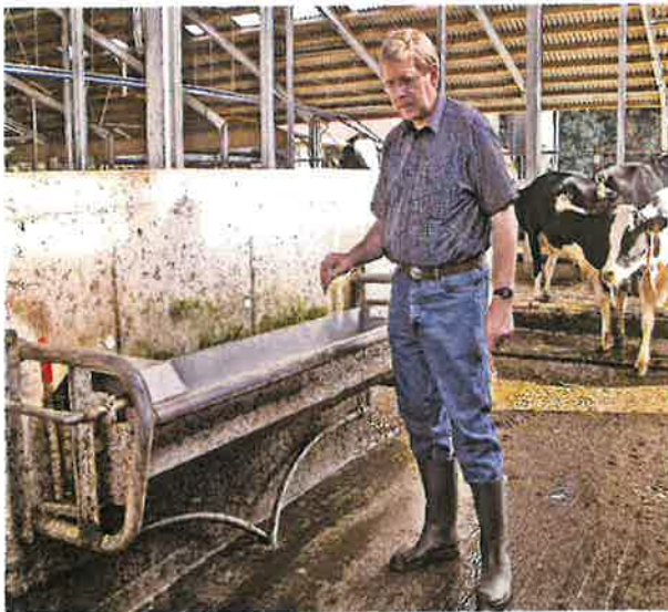
Abb. 11 Trogränke mit Schwimmerventil, Trinkwasserleitung durch Tierkot und Tränkewasser verlegt (Bildquelle Johannes Thomsen, Osterröfnfeld)
